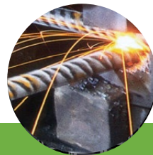
Armadura básica electrosoldada en celosía
